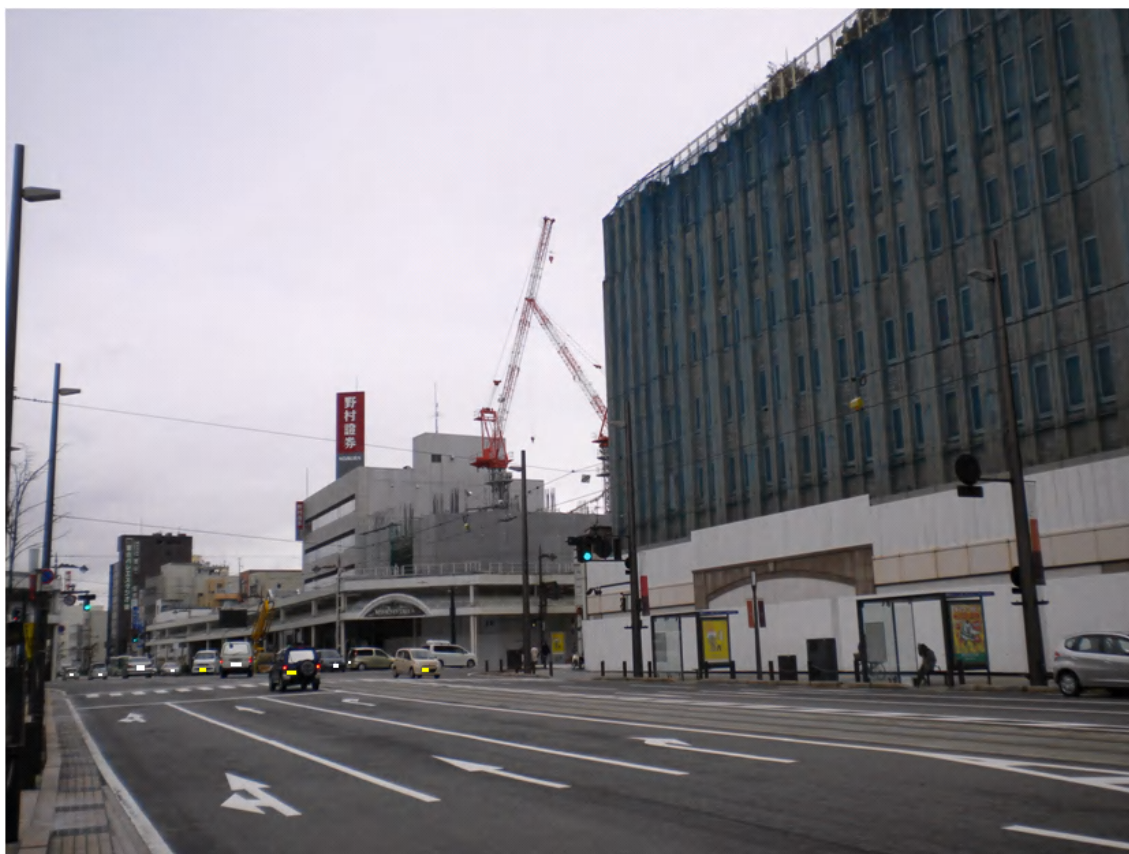
「建設中の『プレミスト西町』」
