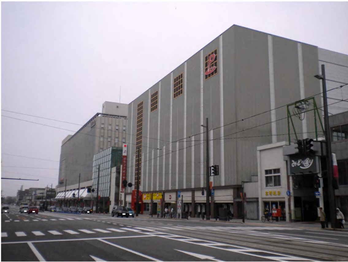
『西町・総曲輪キュービィ』の外観
