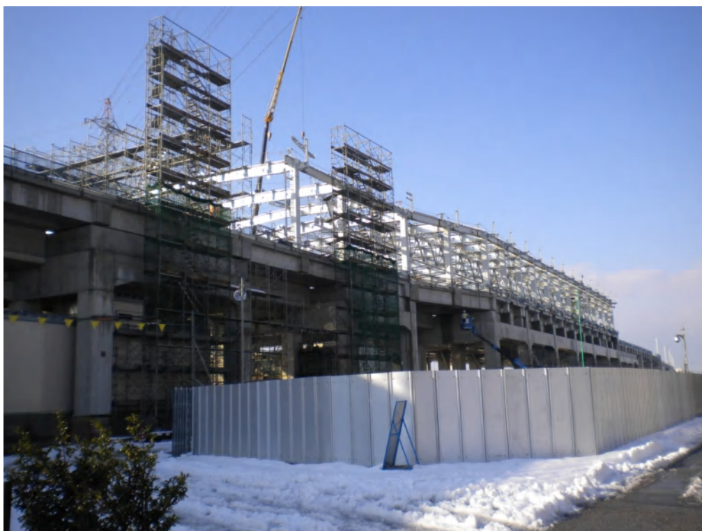
「建設中の新高岡駅（仮称）」
